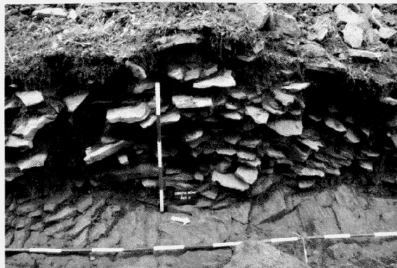
Obř. 9. Otaslavice, okr. Prostějov. „Obrova noha“. Detail kamenné destrukce hradby ve druhém pásmu opevnění. Otaslavice, Bez. Prostějov. „Obrova noha“. Detail der Steindestruktion der Mauer in der zweiten Befestigungzone.
