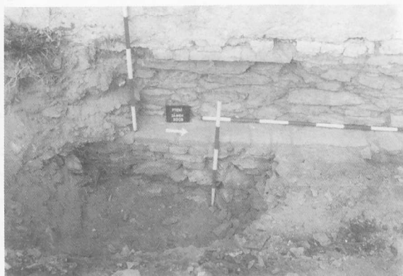
Obr. 40. Ptení, nádvoří pozdně renesančního zámku. Struktura základového zdiva vnitřní obvodové stěny objektu. Ptení, Hof des Renaissance-Schlusses. Struktur der inneren Umfassungsmauer, Fundament.
