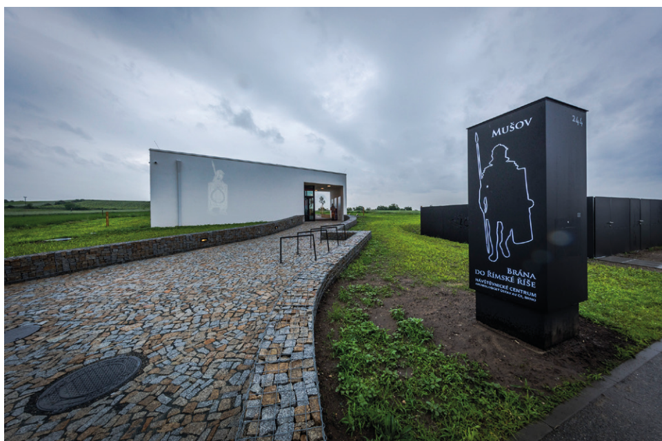
Obr. 1. Pohled zvenčí na budovu Návštěvního centra, v pozadí návrší Hradisko u Mušova. Foto M. Frouz.
