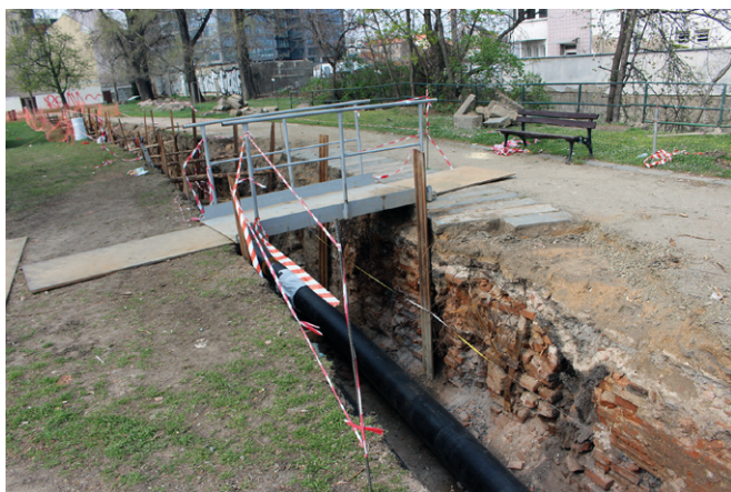
Obr. 21. Brno, Čechyňská, Dornych, Zvonařka. Pohled na plochu výzkumu od jihu. Foto Archaia Brno z. ú.
