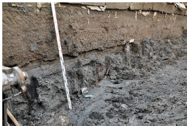
Obr. 63. Litovel, ulice B. Němcové, dřevěné konstrukce se zdí k 900. Foto K. Faltýnek.
