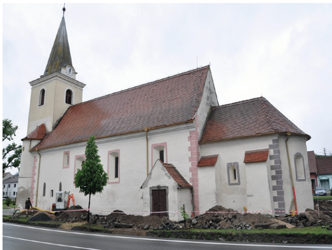
Obr. 93. Kostel Nejsvětější Trojice ve Vladislavi od jihu. Foto Archaia Brno z. ú.
