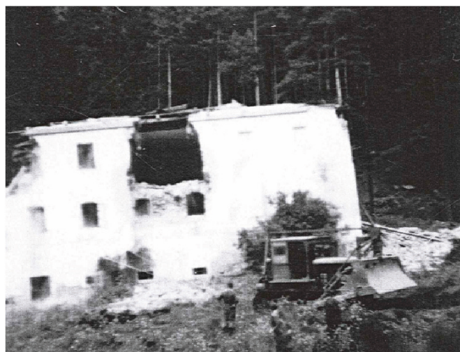
Obr. 3. Boření obytné budovy pomocí pásového traktoru DT-54 v roce 1954. Foto A. Quass.
