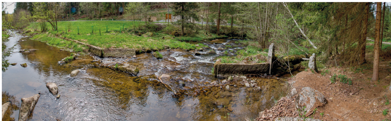
Obr. 11. Panoramatický snímek konstrukce jezu z roku 2024. Vpravo počátek náhonu s kamennými sloupky stavidla. Foto J. Pařez.
