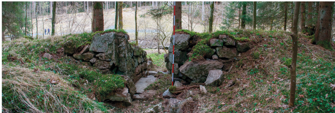
Obr. 12. Panoramatický snímek vyzdění jalového přepadu. Foto J. Pařez.
