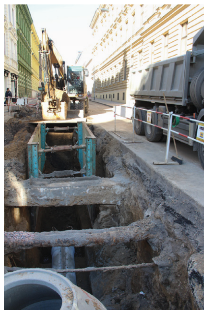
Obr. 6. Brno, Francouzská. Ilustrační záběr od východu na rekonstrukci úseku kanalizace západně od křižovatky s Přadláckou ulicí. Foto Archaia Brno z. ú.
