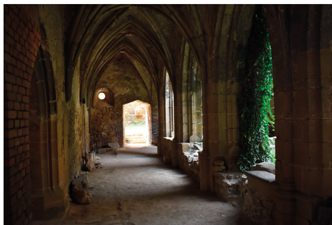
Obr. 2. Dolní Kounice, klášter Rosa coeli. Východní křížová chodba se stopami sondy z roku 2013. Stav k 7. srpnu 2024. Foto J. Kovář.
