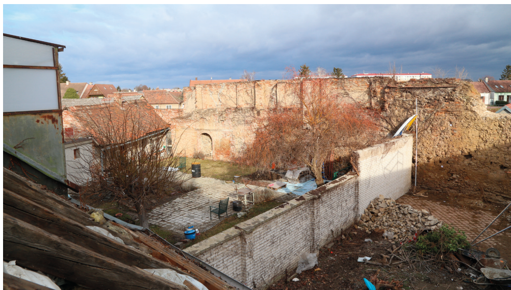
Obr. 9. Veselí nad Moravou. Dochovaný úsek značně přestavěné hradby za č. p. 45. Vpravo je patrný dokumentovaný a dnes z větší části zbořený úsek městské hradby za č. p. 47. Pohled od jihozápadu. Foto Archaia Brno z. ú.
