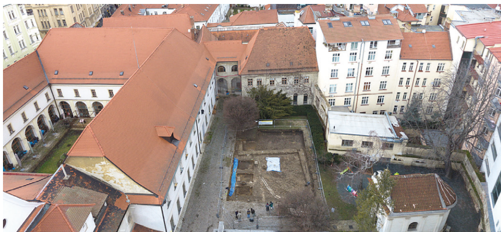
Obr. 9. Brno, ulice Josefská a Orlí. Letecký pohled od jihu na zkoumanou plochu v počátku exkavace; vlevo klášterní budovy. Foto Archaia Brno z. ú.
