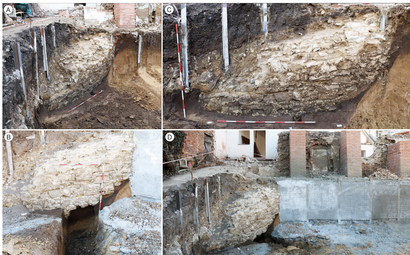
Obr. 8. Veselí nad Moravou, oprava Domu přírody. A – relikt zdiva bašty(?) s. j. 901, pohled od východu; B – totéž zdivo (s. j. 901), které je zahloubeno do patrně staršího výkopu s. j. 501, pohled od severovýchodu; C – zdivo bašty(?) s. j. 901 s patrnou destrukcí tohoto zdiva s. j. 105 a 106, pohled od severovýchodu; D – relikt zdiva bašty(?) s. j. 901 po částečném ubourání. Vpravo je v již částečně zbořeném městské hradbě s. j. 900 patrný zaslepený historický otvor průchodu vedoucí skrz hradbu, pohled od východu. Foto Archaia Brno z. ú.
