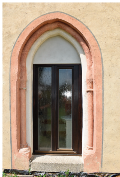
Obr. 6. Tasov. Současný stav portálu odkrytého v jižní stěně raně gotického kostela, dnes fary. Stav k 9. červenci 2024. Foto J. Kovář.
