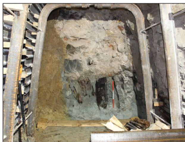
Obr. 6. Brno, ulice Solniční. Profil v ražbě před domem č. 15, kde je patrné zdivo tzv. Weisser Pulver Thurm (959) založené na dřevěných pilotách (965). Archaia Brno z. ú.
