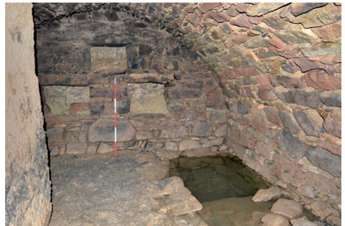
Obr. 46. Lomnička. Interiér sklepního prostoru bývalého hospodářského dvora. Foto P. Kos.
