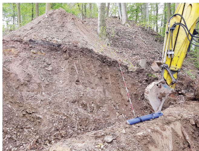
Obr. 15. Dokumentace výzkumu v roce 2024. Průkop pro rekonstrukci propustku od severu se zřetelným geologickým charakterem pahorku lokality, který je tvořený sedimenty břidlice a jílu. Foto J. Unger.
