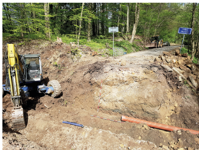
Obr. 14. Dokumentace výzkumu v roce 2024. Pohled na zářez pro vybudování silnice ve 20. letech 20. století od jihu. Foto J. Unger.
