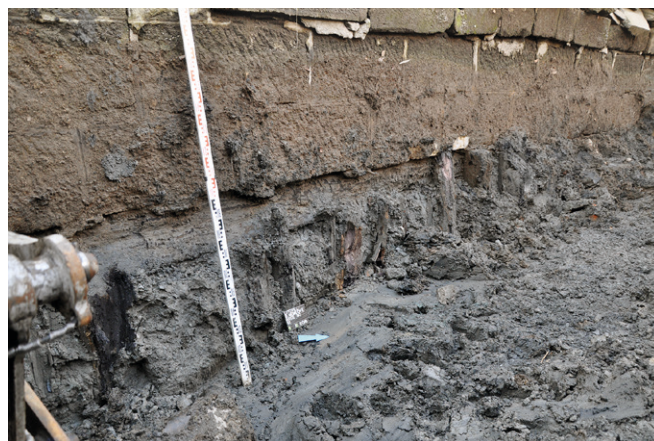
Obr. 63. Litovel, ulice B. Němcové, dřevěné konstrukce se zdí k 900. Foto K. Faltýnek.
