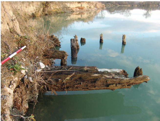
Obr. 16. Mohelnice „Za Moravou“ 2006. Mohutná dřevěná konstrukce mostu nebo lávky (2. polovina 16. století) na břehu štěrkovny (konstrukce 2). Foto V. Vránová.
