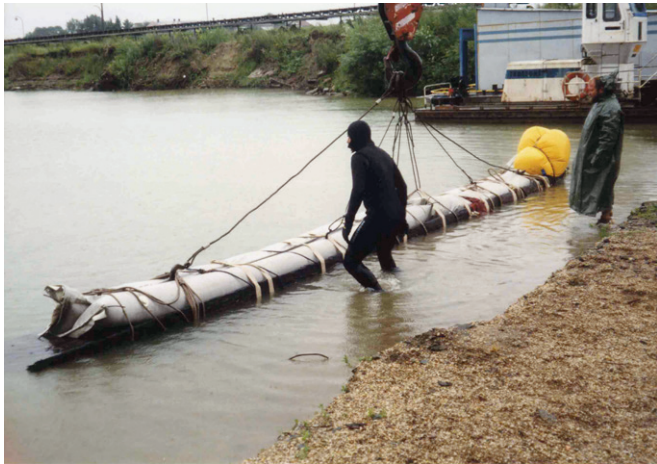
Obr. 7. Mohelnice „U Moravy“ 1999. Transport lodi na druhý břeh štěrkovny pomocí norných stěn a vyzvednut autojeřábem. Foto archiv ACO.
