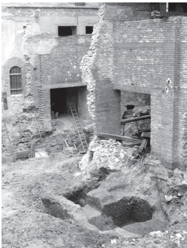
Obr. 20. Brno, Dominikánská 15. Pohled ze Z na výzkum obj. č. 18, 19.
