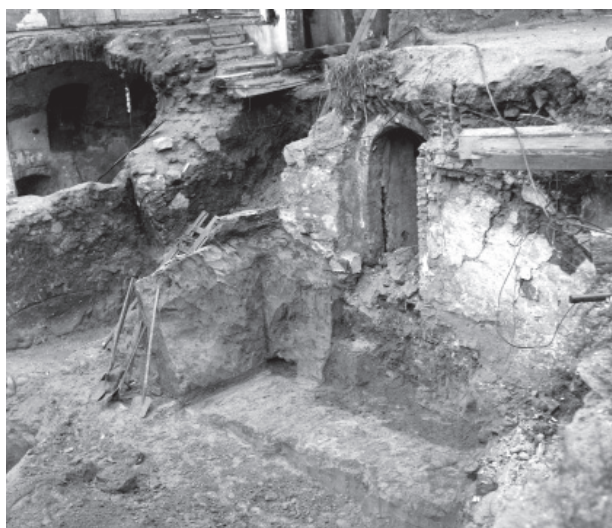
Obr. 36. Brno, Dominikánská 17. Pohled ze S na JZ část objektu č. 63.
