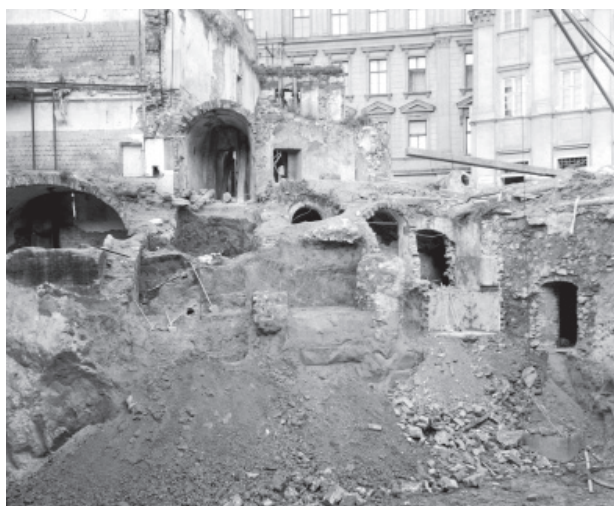
Obr. 6. Západní stěna stavební jámy roku 1985 se zdívá a středověkými zahloubenými objekty v místě domu Dominikánská 17. Uprostřed zčásti odkrytý suterén č. 63. Vpravo gotický sklep (Dominikánská 15), zcela vlevo rovněž gotický suterén.
