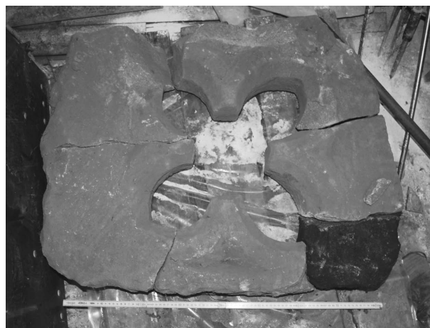
Obr. 79. Hrad Lukov. Okenní kružba ve tvaru čtyřlístu.
