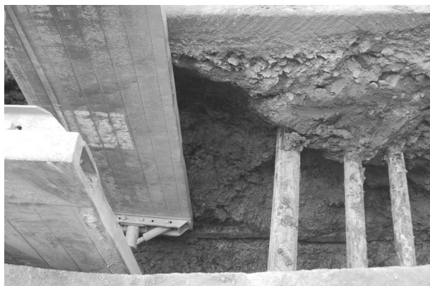
Obr. 71. Konice. Výkop v místě dřevěné stavby.
