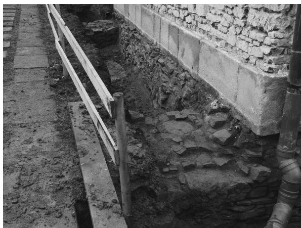
Obr. 127. Zlín-Štípa. Kamenné základy nedostavěného klášterního komplexu.
