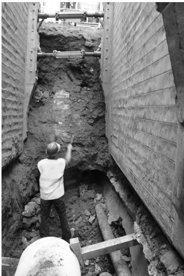
Obr. 17. Běhounská (A020/2009). Začišťování cihlové štolý vodovodu.
