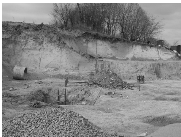
Obr. 12: Dolní Věstonice I, výkop pro nepovolenou stavbu na spodním okraji lokality. Čelo sprašového sesuvu o mocnosti zhruba 3,5 m, na bázi probíhá mírně zahliněná poloha se sutí a poté polohy sprašových hlín. Podloží (ve výkopu pro studnu) je tvořeno jíly; lineární objekt o průřezu ve tvaru U může být reliktem zaniklé úvozové cesty. Fig. 12: Dolní Věstonice I, stratigraphic section at the lower part of the site.
