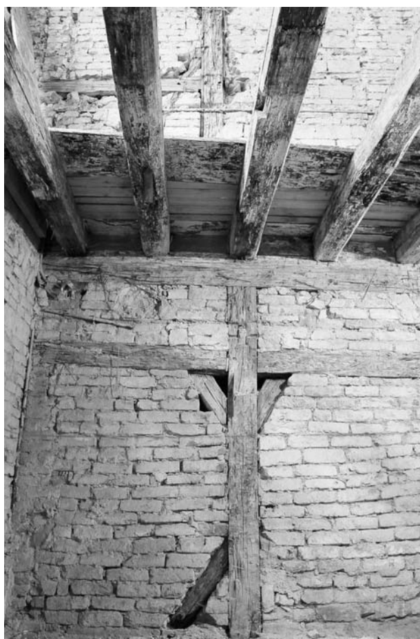
Obr. 13. Mečová 8 (A172/2001), odkrytá hrázděná konstrukce v 1 NP. Mečová Gasse Nr. 8 (A172/2001), entdecktes Fachwerk im 1. oberirdischen Stock.
