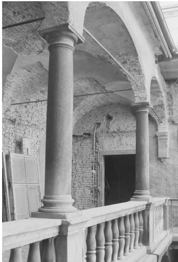
Obr. 19. Dominikánská 9 (A7/2002), arkády 2 NP zadního traktu.
