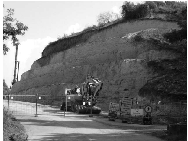
Obr. 3. Dolní Věstonice III, stabilizace svahu po se-sevech. Sprašový profil s polohami fluvialních písčitéch štěrků (mimo obr.), půd a půdních sedimentů, místy přerušovaných poklesy, a tmavou výplní zahloubené rokliny. Foto J. Svoboda.
