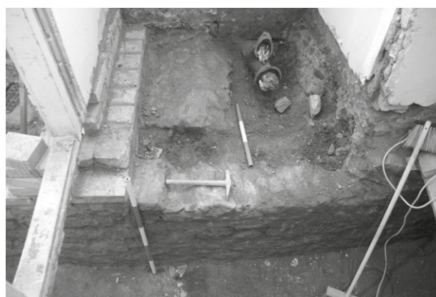
Obr. 41. Bučovice, zámek. Pohled na starší kamenné zdivo, které využívá jeho západní zeď. Starší zdivo vzadu, v popředí cihelná zídka roznášející klenbu sklepů.
